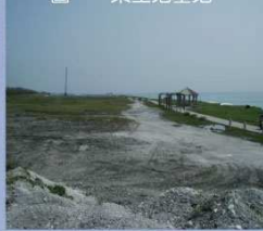
圖一、東工地基地
